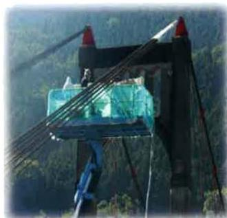
徳島県 吊り橋ワイヤー 防錆施工
